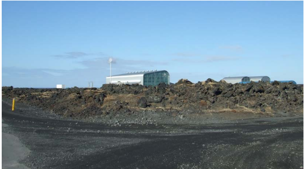
Mynd 1. Stöðvarhús Reykjanesvirkjunar og aðveitustöð til hægri.
